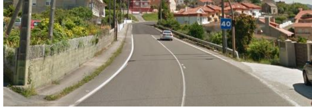
Foto nº12. P.Q. 22+660. Sentido crecente.
