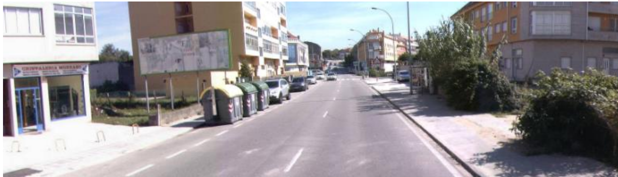
Foto nº1. Inicio das actuacións. P.Q. 21+100. Sentido crecente.
