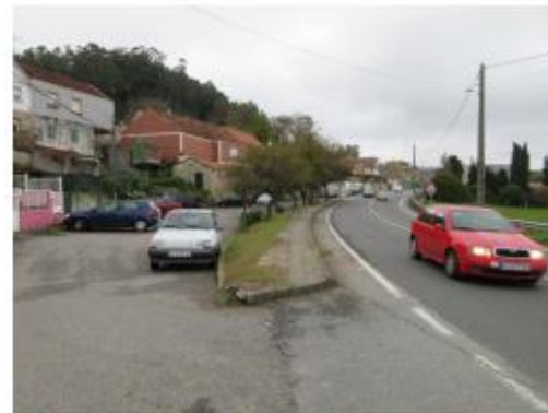
Foto 10: PK 22+500, sentido ascendente. Curva a la izquierda con vía de servicio en el margen izquierdo
