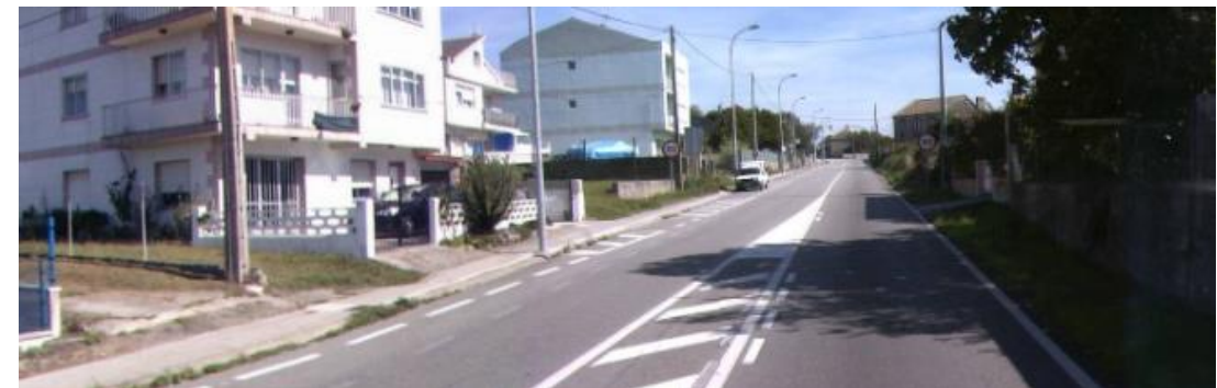
Foto nº5. P.Q.21+600. Sentido crecente. Fin zona carrís centrais.
