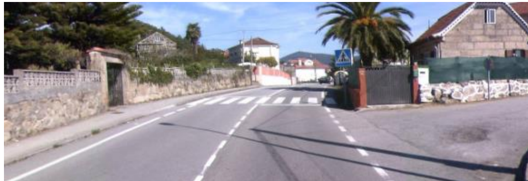
Foto nº10. P.Q. 22+240. Sentido crecente. Paso peóns zona escasa visibilidade.
