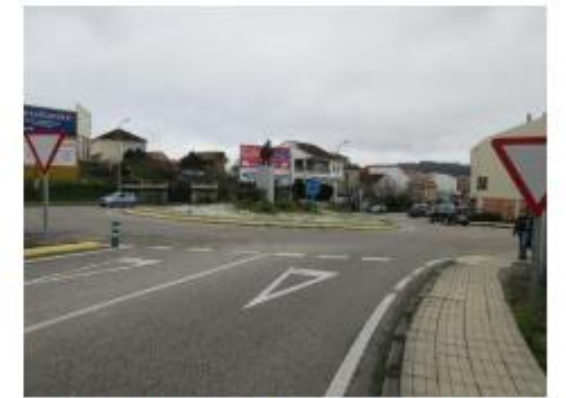
Foto 2: PK 21+350. Glorieta de intersección con la carretera PO-554
