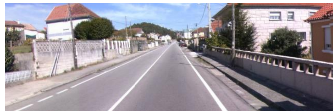
Foto nº7. P.Q. 21+960. Sentido crecente.
