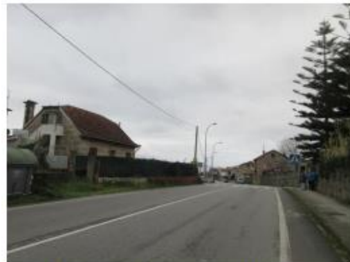
Foto 9: PK 22+400, sentido descendente. Curva a la derecha de radio reducido
