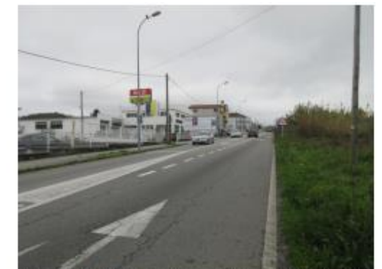
Foto 4: PK 21+450. Intersección con carriles centrales de espera de acceso a establecimiento comercial
