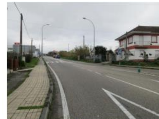
Foto 3: PK 21+400. Acceso a la glorieta y paso de peatones, sentido ascendente
