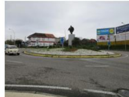
Foto 1: PK 21+350. Glorieta de intersección con la carretera PO-554
