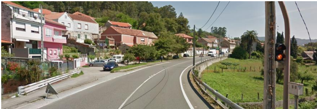
Foto nº11. P.Q. 22+470. Sentido crecente.
